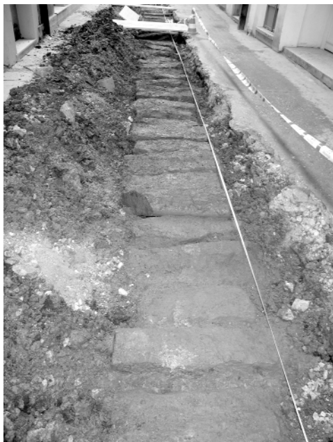
ANTIGA CANALIZACIÓN CUBERTA CON LOUSADO IRREGULAR NA RÚA DE MAZACÁÑAMOS. POR "CARECER DE ESPECIAL INTERESE DESDE O PUNTO DE VISTA PATRIMONIAL" E "POR SER VESTIXIOS DE PRINCIPIOS DE SÉCULO XX" NON SE CONSIDEROU OPORTUNO CONSERVAR O MÁIS MÍNIMO RESTO E FOI COMPLETAMENTE DESTRUÍDA.
