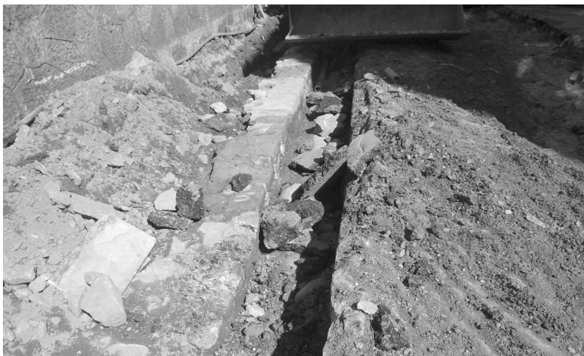
A PALA AGARDA PARA LEVARSE POR DIANTE OS RESTOS DUNHA ANTIGA CANALIZACIÓN NA RÚA DO FERRADOR.
