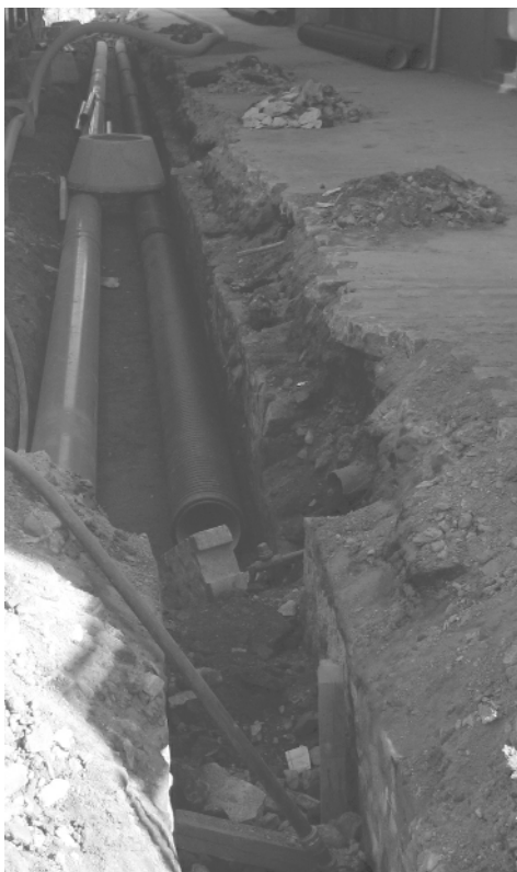
ANTIGA CANALIZACIÓN DESCUBERTA NO TRANSCURSO DAS OBRAS DE SANEAMENTO E PAVIMENTACIÓN DA RÚA RODRÍGUEZ CADARSO, ANTES RÚA DO REGO.
