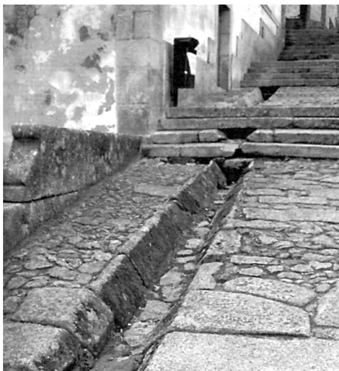
CANALIZACIÓN DE AUGA NUNHA RÚA EN TUI.
