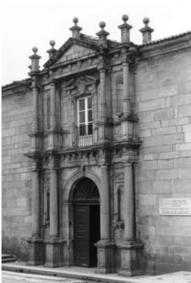
FACHADA O IES ROSALÍA DE CASTRO
