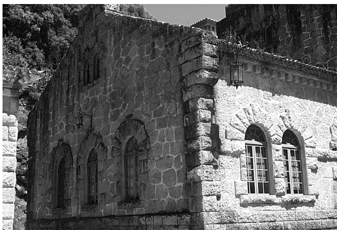
FACHADA NORTE. NESTA TOMA PODE APRECIARSE A VERSATILIDADE DO GRANITO NAS DIFERENTES SOLUCIÓNS PARA OS MUROS, VANS, ZÓCOLO, ESQUINAIS, CHEMINEAS, MODILLÓNS, ETC. O GRANITO APARECE EN CARAS BASTAS NAS QUE SE PRESCINDE DO TRABALLO FINO DE CANTEIRO OFRECENDO UN ASPECTO DE PLACAS SOBRESAÍNTES.
